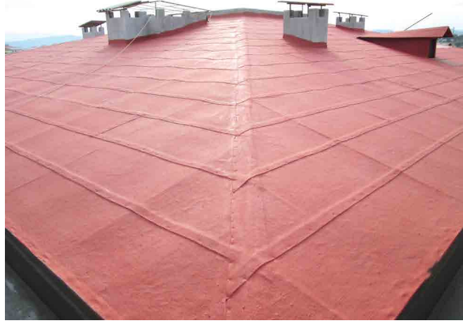
Görsel 31: Çatı Kaplama Örtüsü
